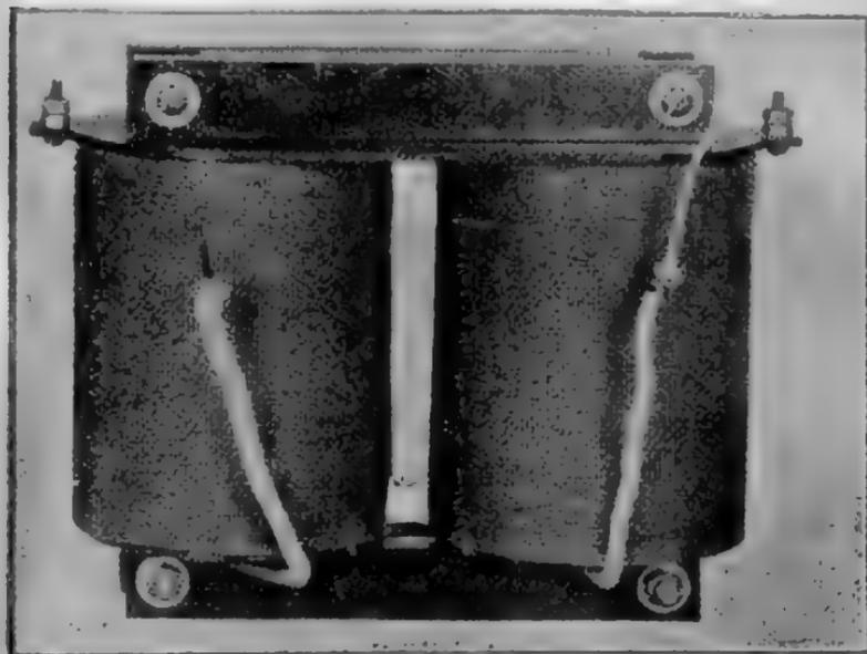
Fig. 181. — Trasformatore in salita per la carica della batteria di condensatori
